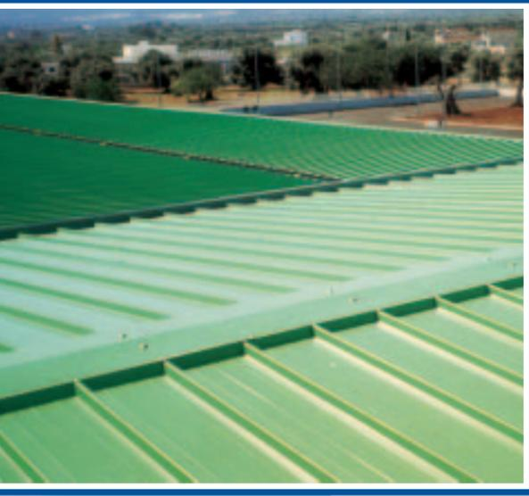
Pannello metallico autoportante coibentato in lana di roccia destinato alle coperture e alle pareti che richiedono elevate prestazioni di resistenza al fuoco ed elevate prestazioni fonoisolanti.
