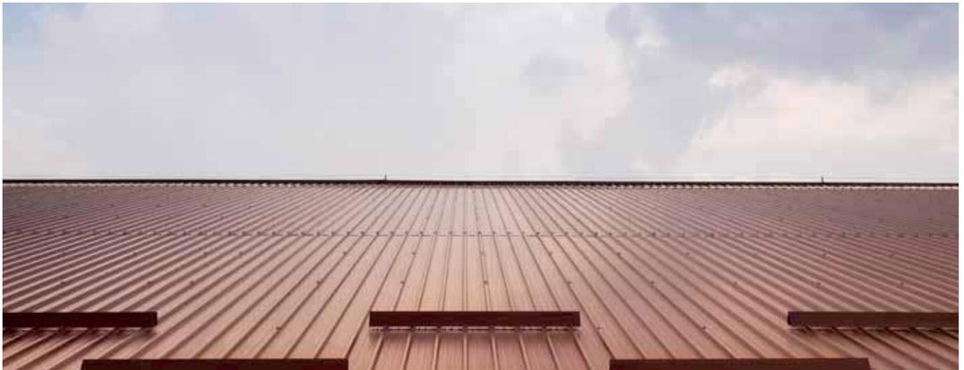
Sandwichpaneel mit profilierter Außen- und Innenschale aus Stahlblech für Dächer, isoliert mit Polyurethanschaum, profiliertes Außenblech mit 5 Sicken zur Steigerung der Festigkeit gegenüber statischen und dynamischen Lasten. Die Befestigung ist sichtbar und erfolgt mit speziellen Metallkappen mit Dichtung.
